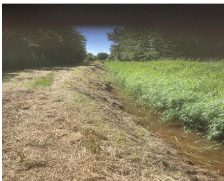
Kosig Kanal under renovering
